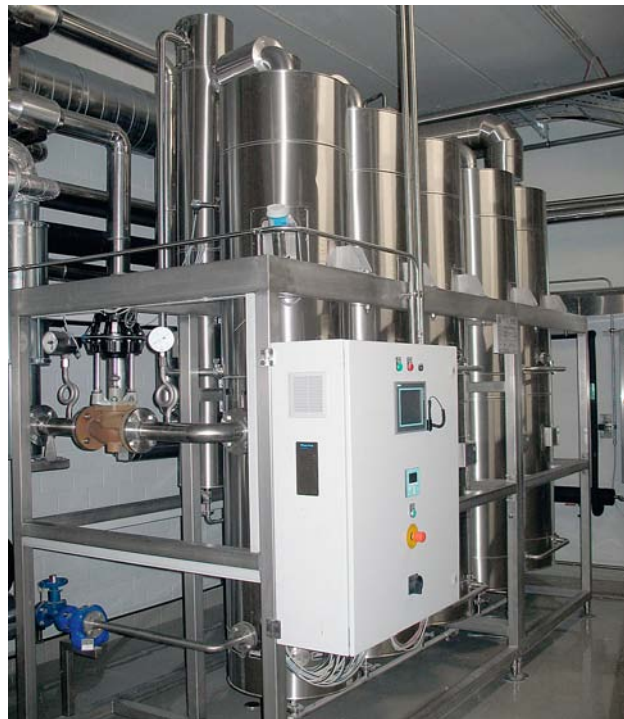
WFI-Destille der Firma PharmaTec GmbH Dresden.
